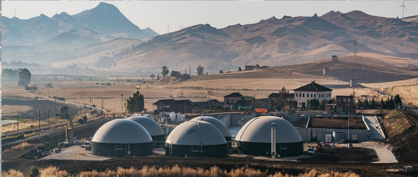
L'ottenimento del biometano avviene in due fasi: produzione del biogas grezzo - prevalentemente attraverso la digestione anaerobica di biomasse - e successiva rimozione - upgrading - delle componenti non compatibili con l'immissione in rete (CO<sub>2</sub>).
