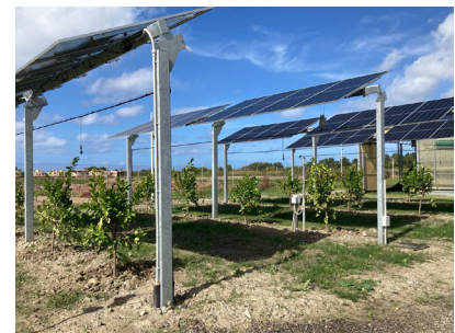
Figura 5: Dimostratore agrivoltaico elevato innovativo in pieno campo, con coltivazione di agrumi, collocato a Scalea (CS).
