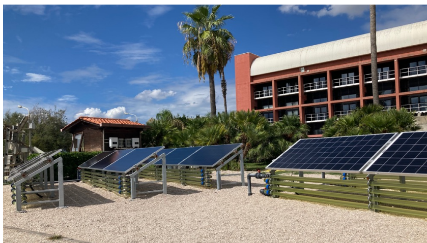
Figura 2: Impianto Algovoltaico™. Il dimostratore realizzato alla fine del 2023 presso il Centro Ricerche ENEA di Portici è costituito da due generatori distinti, uno realizzato con 9 moduli monofacciali, l'altro realizzato con 9 moduli bifacciali, disposti su tre file da tre per una potenza nominale del singolo sottosistema di 3,4kW p . I fotobioreattori sono integrati in entrambi i sottosistemi, e allo scarico dei circuiti è collegata un'unica centrifuga per la separazione delle microalghe dall'acqua di coltura e la raccolta (~30kg/anno). Le prestazioni dell'impianto sono monitorate e valutate, e sono in corso attività di ottimizzazione in vista di ulteriori attività di ricerca.
